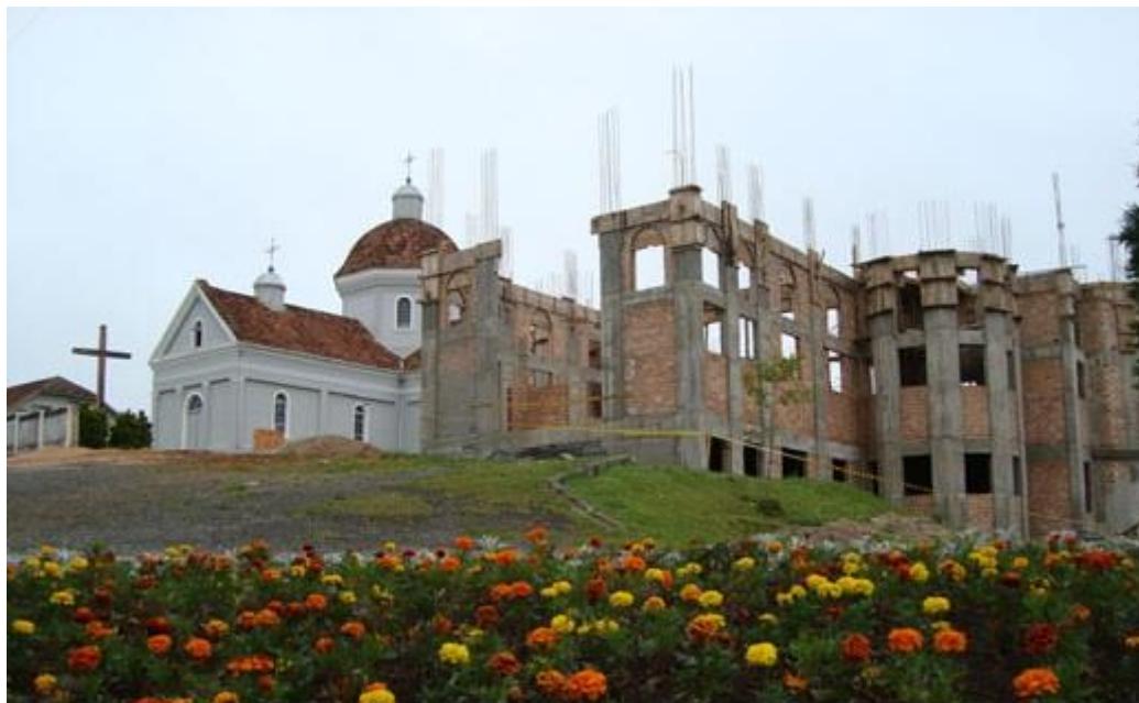
Figura 13: Obras na nova Igreja da Santíssima Trindade. Acervo Prefeitura Municipal de São José dos Pinhais, 2009
