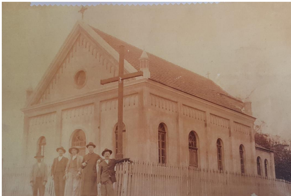
Figura 9: Capela de alvenaria. 1922. Acervo: família Incote
